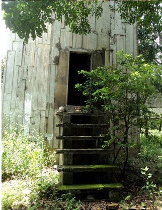
Đền thờ chân Nghĩa Dưng Đài.-Trung Thu 2011, photo by TQGO
